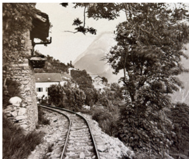
Während dem Bau der BLS (ca. 1910) führte die «Dienstbahn» auf dem Trasse der heutigen Strasse durch den Dorfteil «Wirmschland» Eggerberg.
