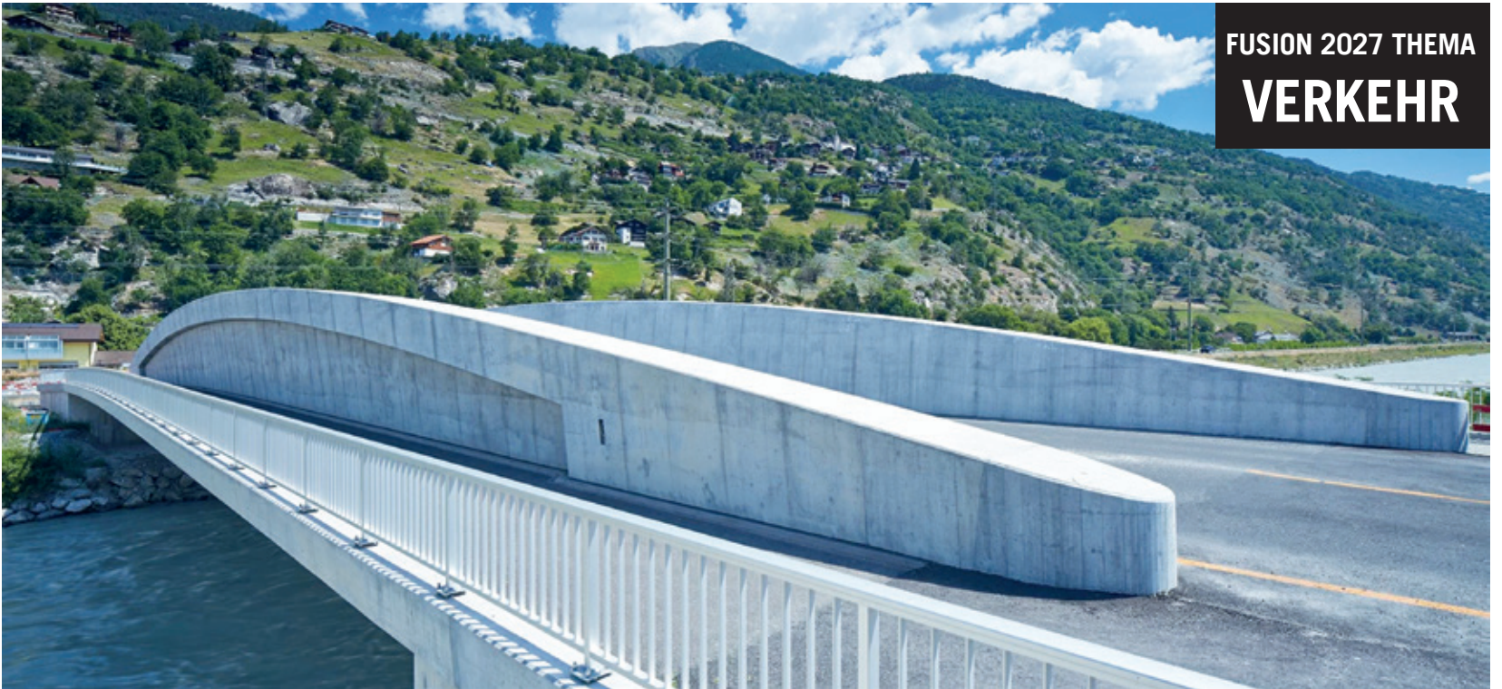
Die Baltschiedner Brücke (2014) ist gleichzeitig Bindeglied und Lebensader der drei zu fusionierenden Gemeinden Baltschieder, Eggerberg und Visp. Sie ist 61 m lang und 19 m breit und überquert den Rotten und den Laldner Kanal. © Bänziger Partner
