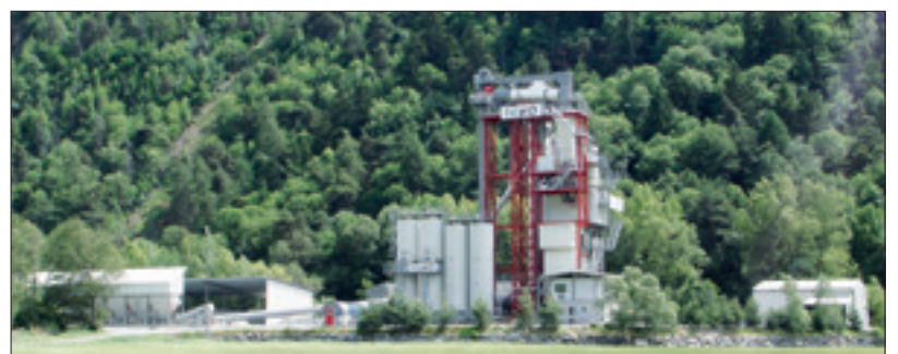
Die BEWO-Anlage, das bedeutendste Belagsfabrikations- und Lieferwerk des Oberwallis.
