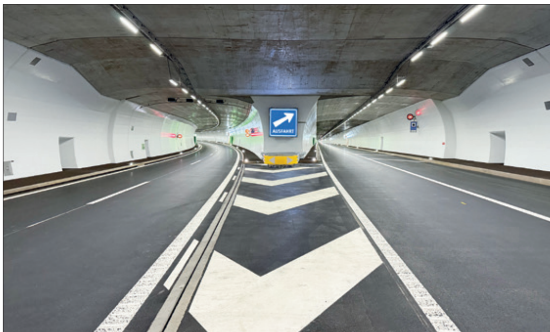
Am 24. Juni wird der letzte Tunnel der Südumfahrung Visp der A9 eröffnet – ein technisches Meisterwerk.
