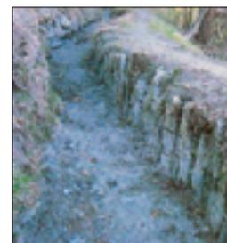
erdebüscheln auf einer Länge von ca. 232 m nachgestopft. Die exponierten Bäume entlang der Wässerwasserleitung wurden durch den Forstbetrieb Visp und Umgebung entfernt.
