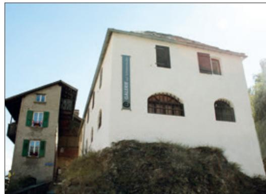
Die erdberührten Wände haben durch die aufsteigende Feuchtigkeit Schaden genommen. Das alte Mauerwerk ist durch Feuchtigkeit und Salze belastet. Neben den natürlichen Ursachen können fehlende oder fehlerhafte Abdichtungen zur Durchfeuchtung des Mauerwerks geführt haben. Eine umfassende Sanierung des Mauerwerks drängt sich so auf.
