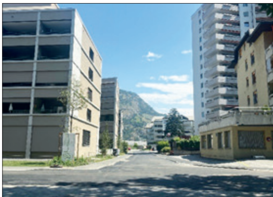
Die sanierte Gemeindestrasse Litternaweg sowie die östliche Einfahrt in den Brückenweg
